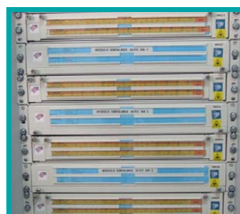
Repartidor modular de fibra optica
